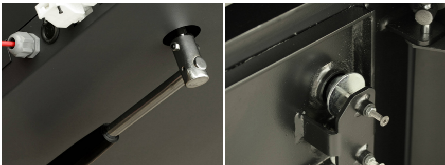
Nettoyage des turbulateurs
